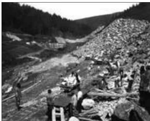
Výstavba přehrady z lomového kamene
