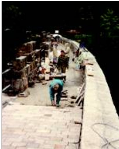
Rekonstrukce koruny hráze v září 1996 / Přehrada po celkové opravě v roce 1997
