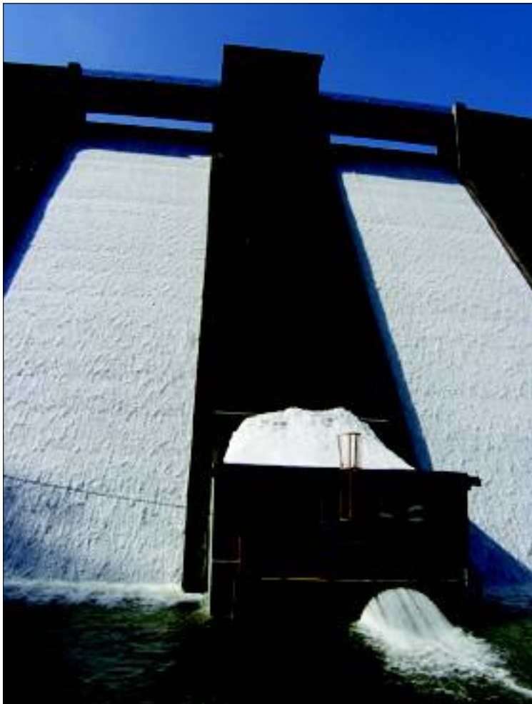
Přepad vody přes přelivy na jaře 2005
