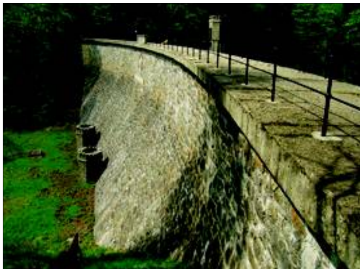
Návodní a vzdušná líc hráze
