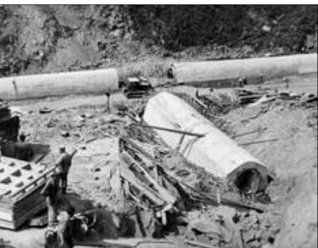
Výstavba křížení injekční a komunikační štol v létě 1961 / Vypuštěná nádrž při rekonstrukci hráze v roce 1982 / Prodloužení štol před dosypáním při rekonstrukci hráze v listopadu 1982
