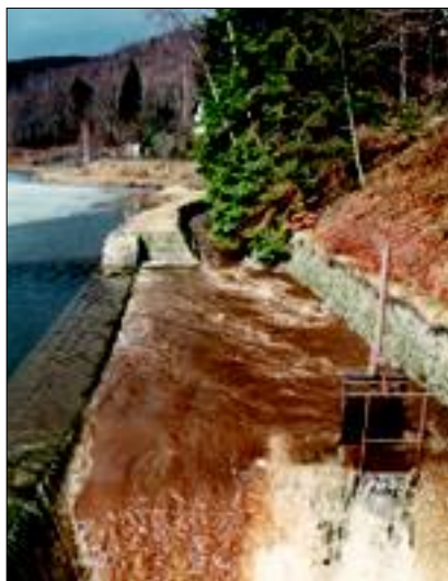
Obtokový kanál ve funkci při povodni v březnu 2000 / Přelití rozdělovacího objektu nad nádrží při povodni v srpnu 2002
